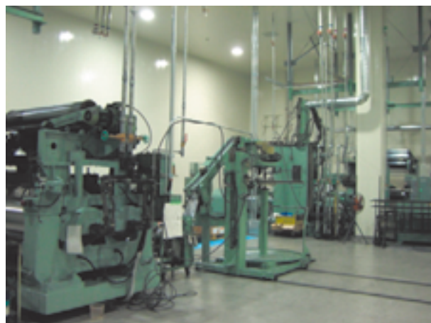
図5 配合・混合室
