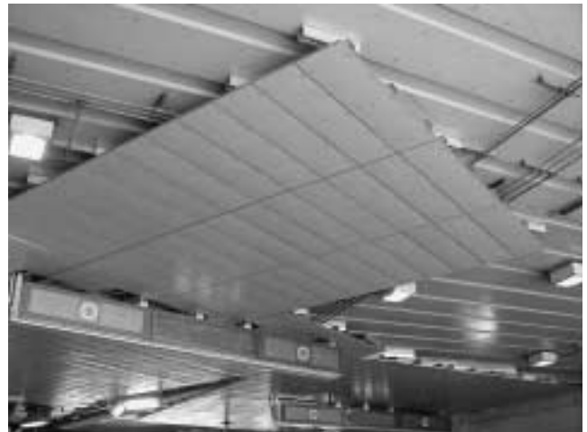
図6 ETC用電波吸収パネルの設置状況
